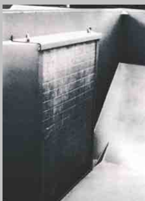
Widok szczelin od wewnątrz
